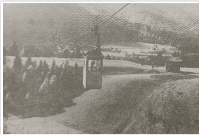
Abb. 2: Die Seilbahn auf der Strecke. Foto: privat
