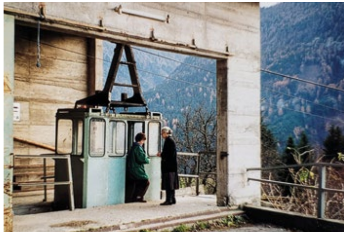
Abb. 3: Seilbahnstation St. Jakob. Foto: privat
